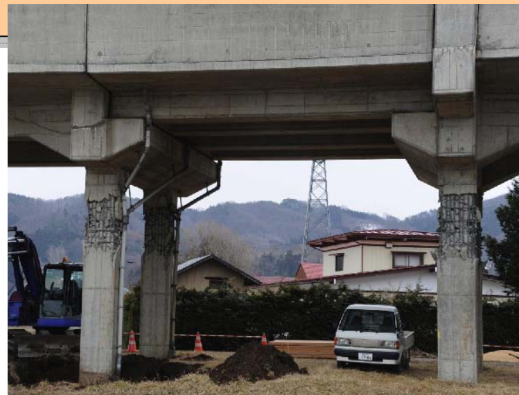
鉄道ラーメン高架橋の被害 土木学会東日本大震災被害調査団緊急地震被害調査報告会より
