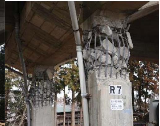
鉄道ラーメン高架橋の被害 土木学会東日本大震災被害調査団緊急地震被害調査報告会より
