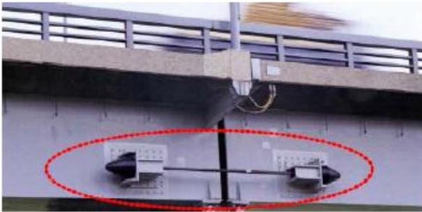
—縁端拡幅ブラケットによる桁の落下防止—
