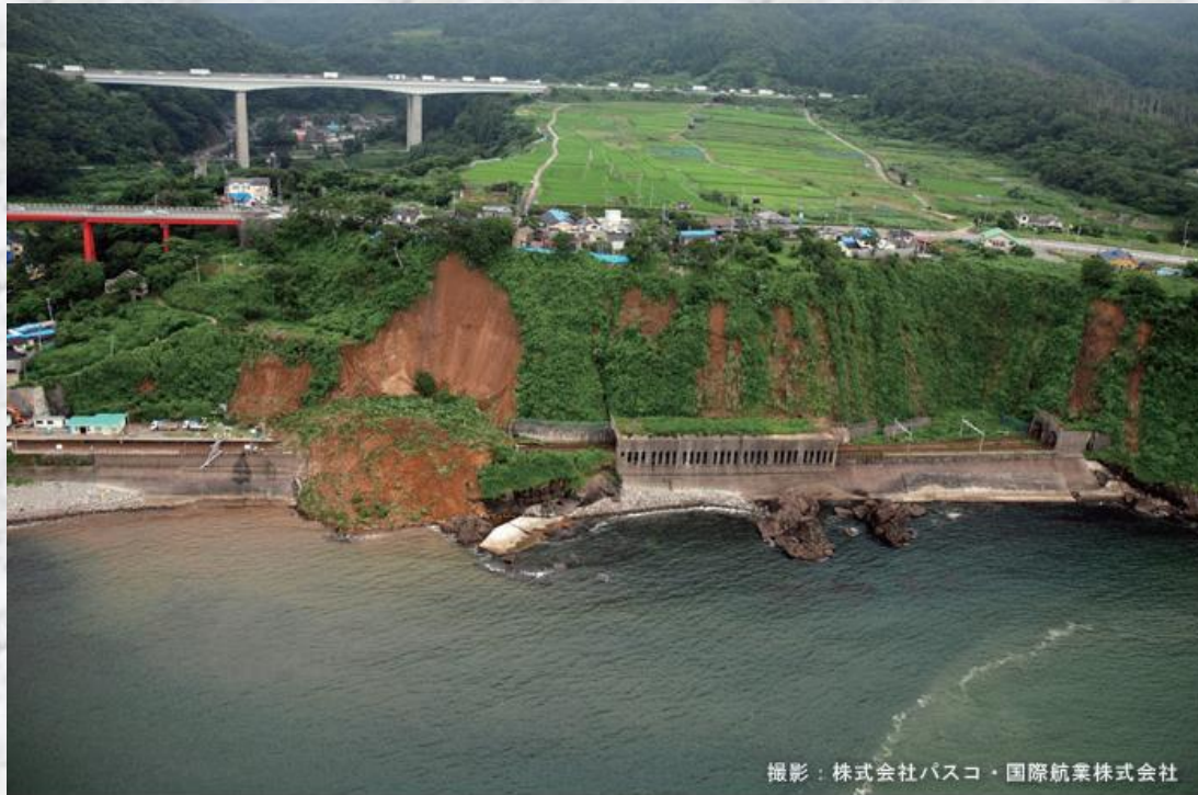
(e) 青海川付近の大規模崩壊（提供 パスコ）
