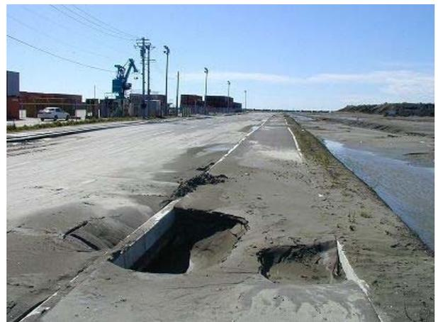
(左) マンホールの浮上り：豊頃駅付近で最大級の浮上1.4m(路面自体が0.5m程度沈下している)。
