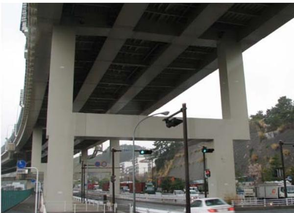
写真-1.1 鋼製橋脚（ラーメン式）
