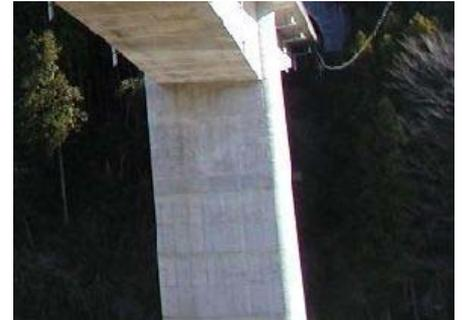
写真-1.3 壁式橋脚(矩形断面)
