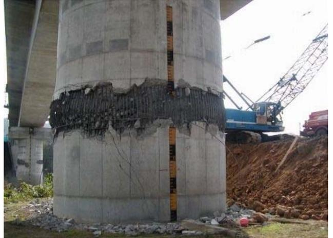
☞ 円形断面の柱を有する張出式橋脚で、地震によって段落とし部の全周に渡ってかぶりコンクリートの剥落および軸方向鉄筋のはらみ出しが発生している。帯鉄筋はフックのない重ね継手であったため、鉄筋内部のコンクリートの拘束効果はなく、一部帯鉄筋が落下している（左）。
