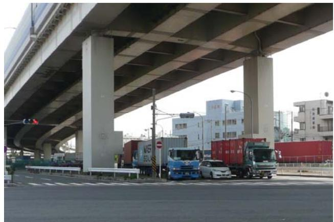
写真-1.2 鋼製橋脚（単柱式）
