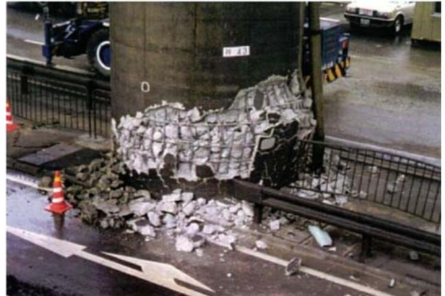
☞ 円形断面の柱を有する張出式橋脚で、橋軸方向の地震によって柱基部で曲げ破壊に至った事例である。地震による繰り返し荷重により、かぶりコンクリートは剥落し、主鉄筋ははらみだし、さらに鉄筋内部のコアコンクリートの破壊に至ったと推察される。
