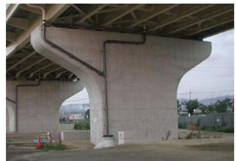
写真-1.5 張出式橋脚(矩形断面)
