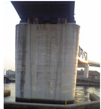
写真-1.4 壁式橋脚(小判型断面)
