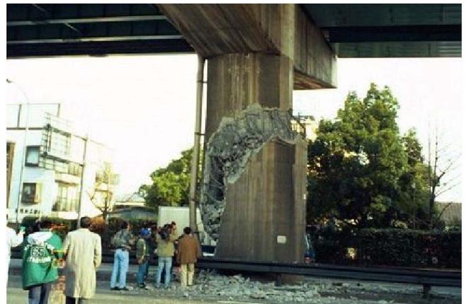
☞ 円形断面の柱を有する張出式橋脚で、橋軸方向の地震力によってせん断破壊に至った事例である。段落とし位置付近から斜めひび割れが進展し、拡大したものと推察される。
