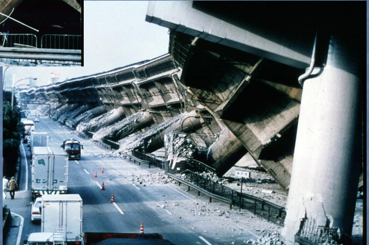
ピルツ橋の倒壊/兵庫県南部地震(1995)
