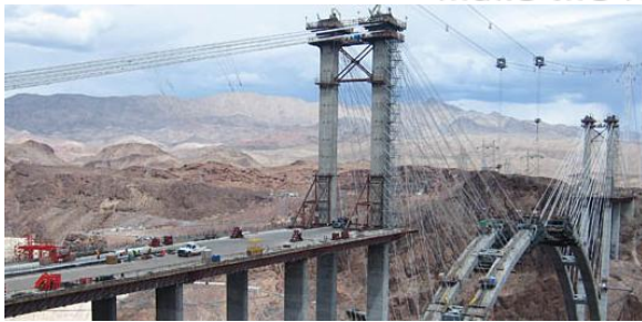
米国コロラドリバー橋
