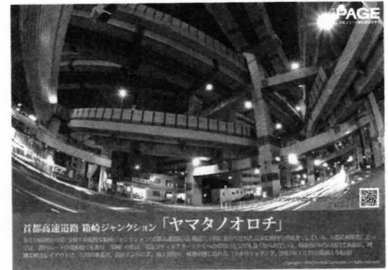
(b) 首都高速道路箱崎ジャンクション：その複雑な幾何学形状は写真愛好家の激写スポットになっている。
