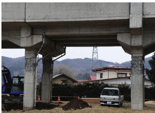
図 2 構造物の損傷事例（出典：土木学会 東北地方太平洋沖地震 被害調査報告）
